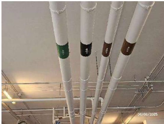
รูปที่ 35 ท่อรวบรวมน้ำเสียจากห้องพักมูลฝอย
