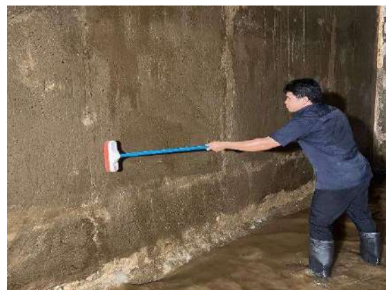
รูปที่ 20 การล้างถังน้ำใช้
