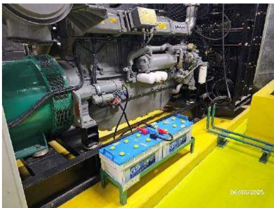
รูปที่ 89 แบตเตอรี่สำรอง
