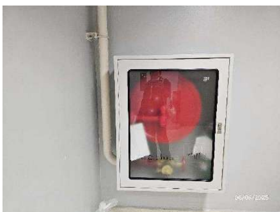
รูปที่ 54 ตู้เก็บสายฉีดน้ำดับเพลิงพร้อมอุปกรณ์ (Fire Hose Cabinet : FHC) ใ้ภายในอาคาร
