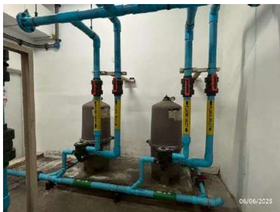
รูปที่ 83 ระบบกรองน้ำสระว่ายน้ำ
