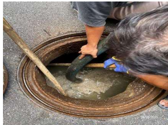
รูปที่ 12 การสูบล้างถังและตะกอน
