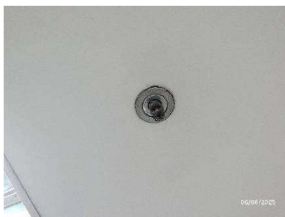
รูปที่ 55 ระบบหัวกระจายน้ำ ดับเพลิงอัตโนมัติ (Sprinkler System)
