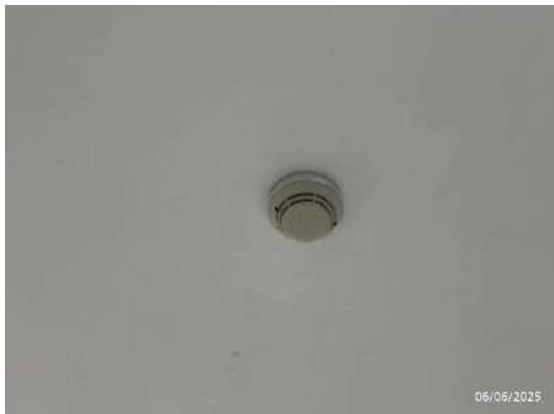
รูปที่ 57 เครื่องตรวจจับควัน (Smoke Detector)
