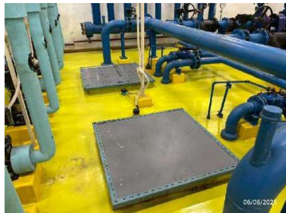
รูปที่ 15 ฝาลังเก็บน้ำสำรอง บริเวณถังเก็บน้ำใต้ดิน
