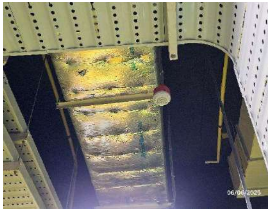
รูปที่ 58 เครื่องตรวจจับความร้อน (Heat Detector)
