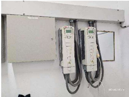
รูปที่ 47 อุปกรณ์ปรับความเร็วรอบมอเตอร์ VSD
