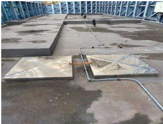
รูปที่ 16 ฝาดังเก็บน้ำสำรอง บริเวณฝาดังเก็บน้ำชั้นหลังคา
