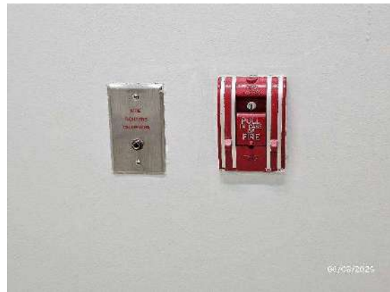
รูปที่ 59 เครื่องแจ้งเหตุโดยใช้มือดึง (Manual Station)
